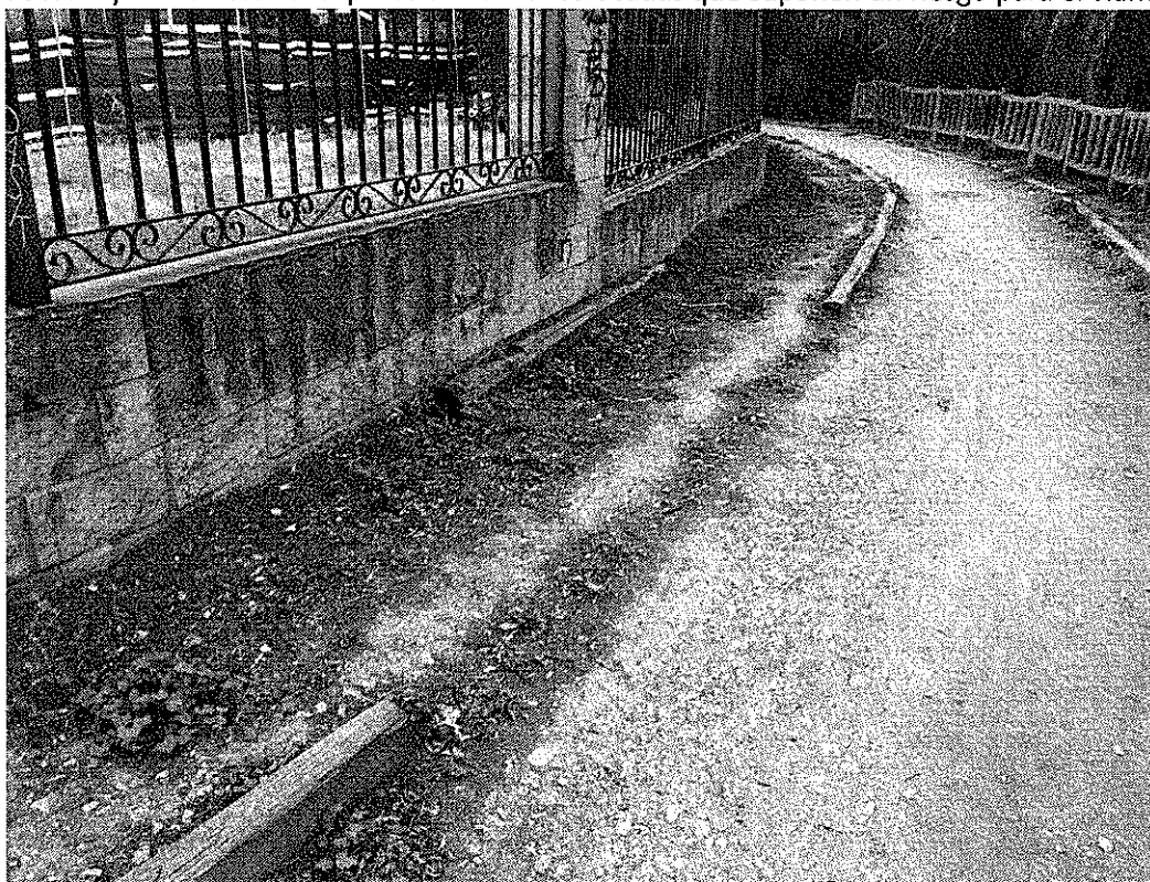
Fotos 1 y 2: Traviesas desaparecidas o mal colocadas que suponen un riesgo para el viandante
