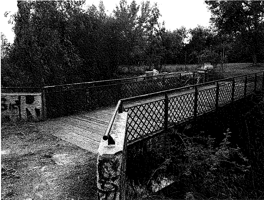
Fotos 7 y 8. Puentes sobre el Camarmilla con la barandilla oxidada y cárcavas en sus accesos.
