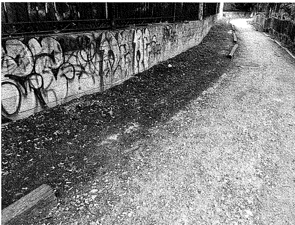
Fotos 1 y 2: Traviesas desaparecidas o mal colocadas que suponen un riesgo para el viandante
