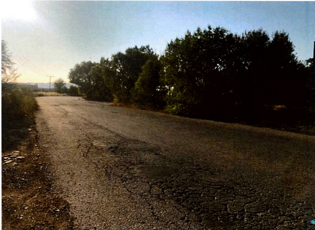
Estado del pavimento de la vía
