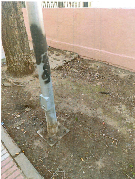
Foto 3: Ejemplo de farola en mal estado.
