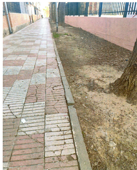
Foto 4: Calzada levantada y sucia.
