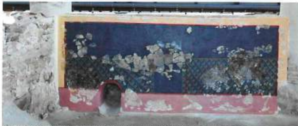
Figura 34. Restauración e instalación pintura mural de pretil norte del lado este del peristilo por el exterior. Servicio Municipal de Arqueología.
