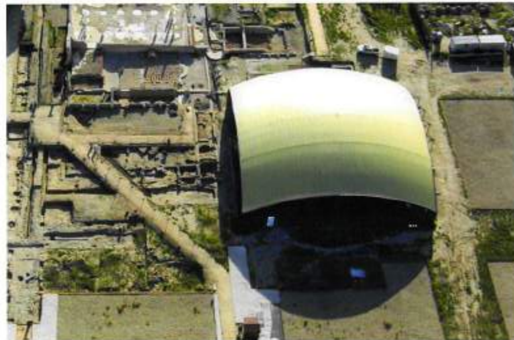
Figura 12. Cubierta de la Casa de los Grifos. Servicio Municipal de Arqueología.
