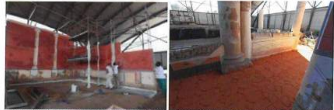
Figuras 23 y 24. Instalación pinturas murales de la estancia E, anastilosis de columnas del muro norte del peristilo, recreación de solado de ambulacra. Servicio Municipal de Arqueología.
