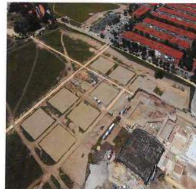
Figura 10. Cubierta de la Casa de los Grifos. Servicio Municipal de Arqueología.
