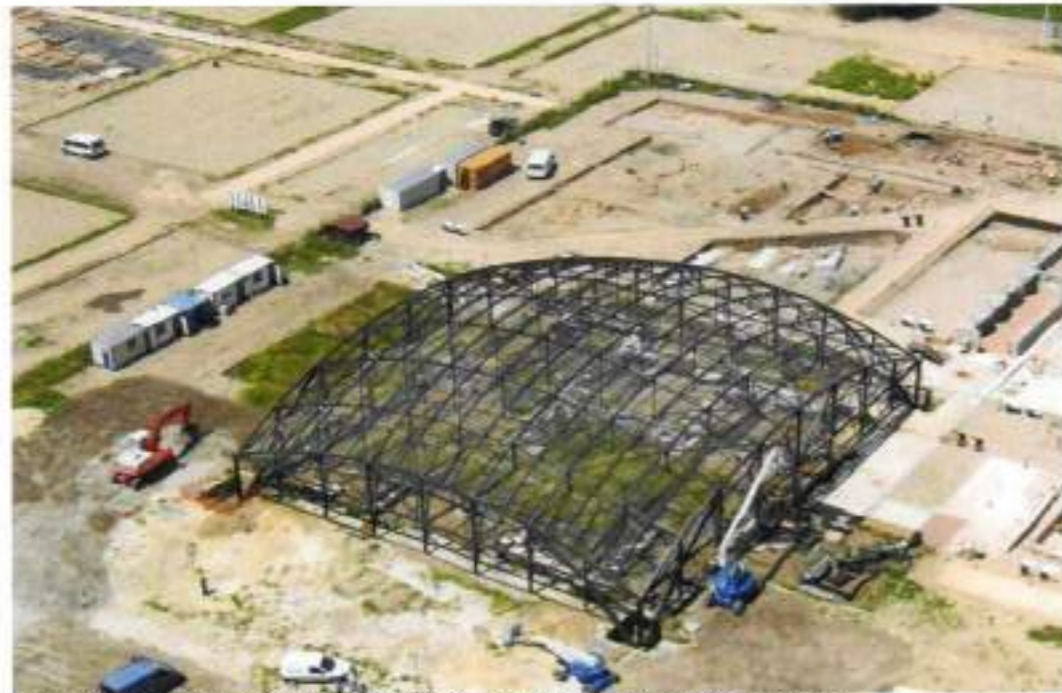
Figura 11. Cubierta de la Casa de los Grifos. Servicio Municipal de Arqueología.
